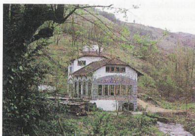
Mugairiko zentral elektrikoa.
