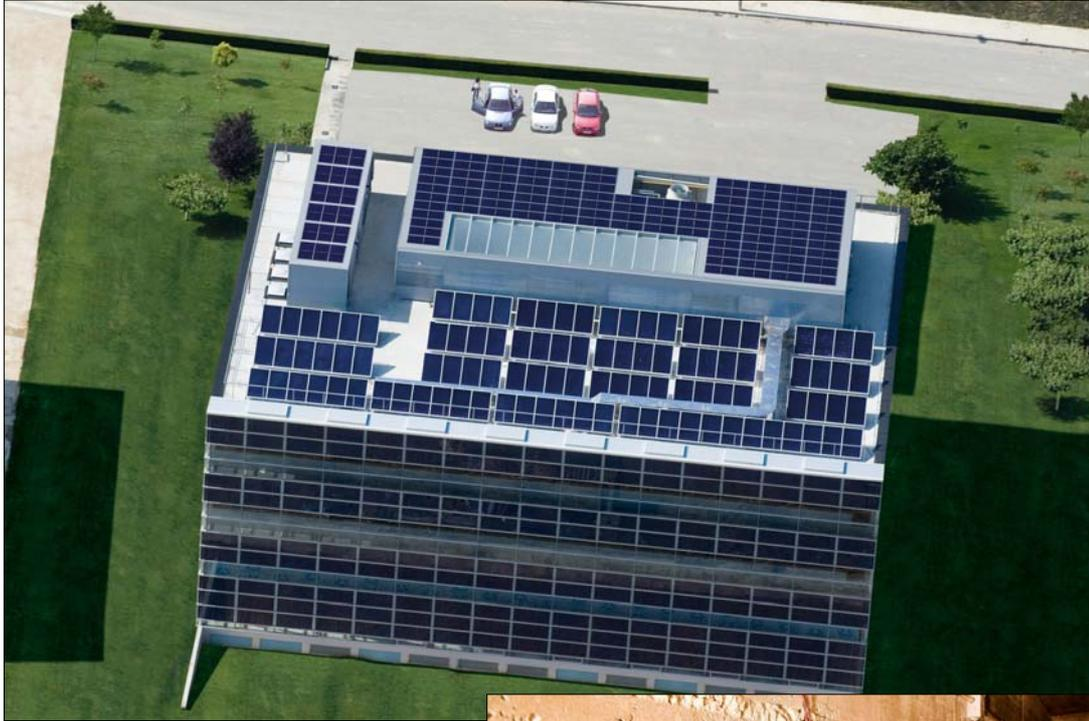
*Paneles solares sobre la cubierta y fachada sur del edificio. A la derecha, tubos soterrados que integran el sistema geotérmico.*
